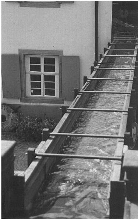
Der Abbildung ist zu entnehmen, dass die Rinne einen rechteckigen Querschnitt hat, etwa mit dem Seitenverhältnis 2:1. Beschränkt man sich auf rechteckige Querschnitte, dann ist dieses Verhältnis optimal hinsichtlich des Fassungsvermögens der Rinne (das Extremum einer quadratischen Funktion lässt sich in der Sekundarstufe I bestimmen).
